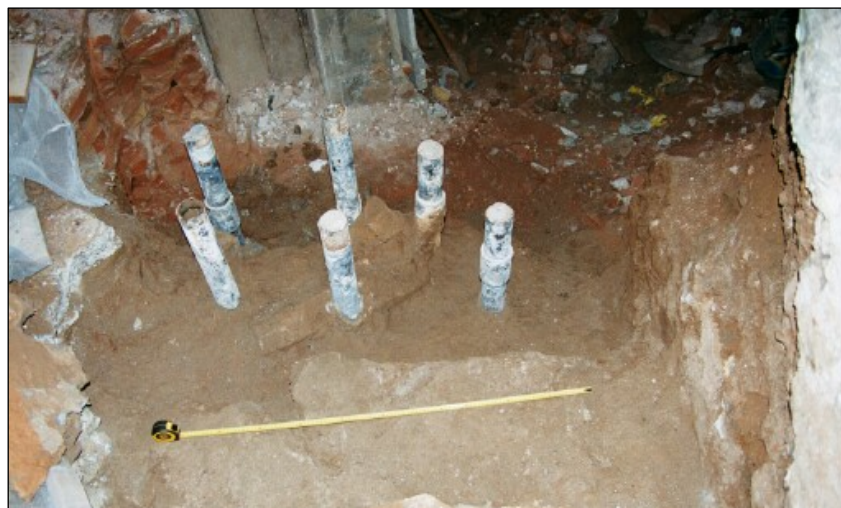
Fotografia 19 : Inici del sondeig de la sabata de fonamentació
