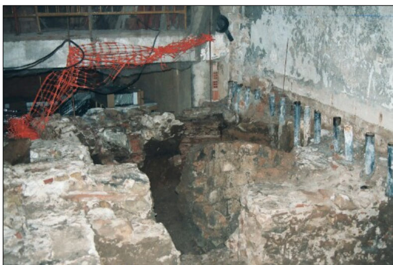
Fotografia 12 : Vista dels murs riostra a l'inici de la segona fase
