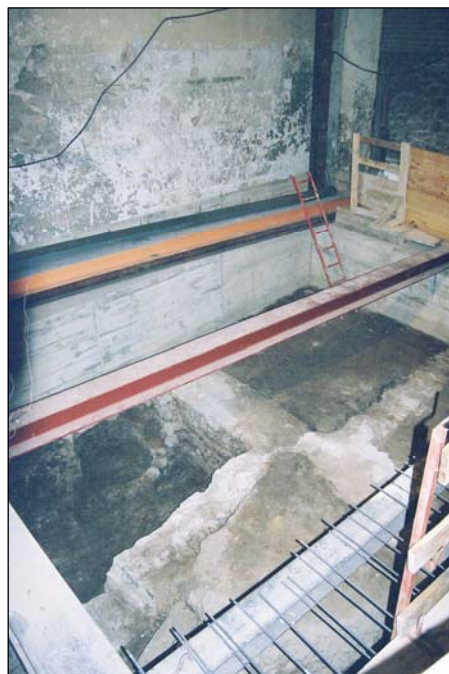
Fotografia 23 : Sector 1 i 2 a l'inici de la fase 7
