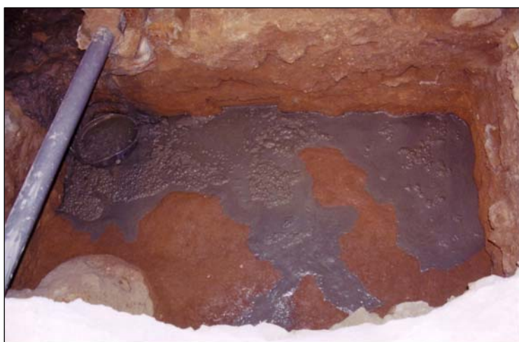
Fotografia 7 : Interior de la fonamentació de la torre de la muralla
