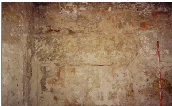
Fotografia 2 : Detall del llenç de muralla
