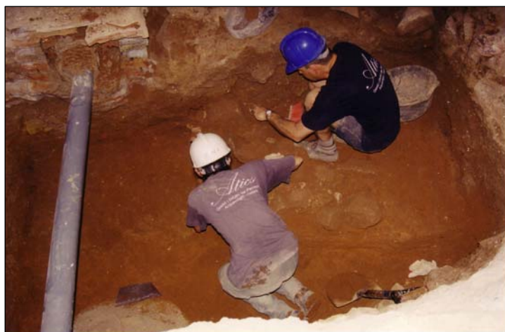
Fotografia 5 : Treballs a l'interior de la fonamentació de la torre de la muralla
