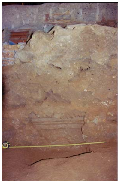
Fotografia 6 : Detall d'un element arquitectònic reaprofitat en la fonamentació
