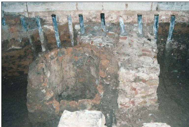
Fotografia 11 : Pou tallat per murs riostra
